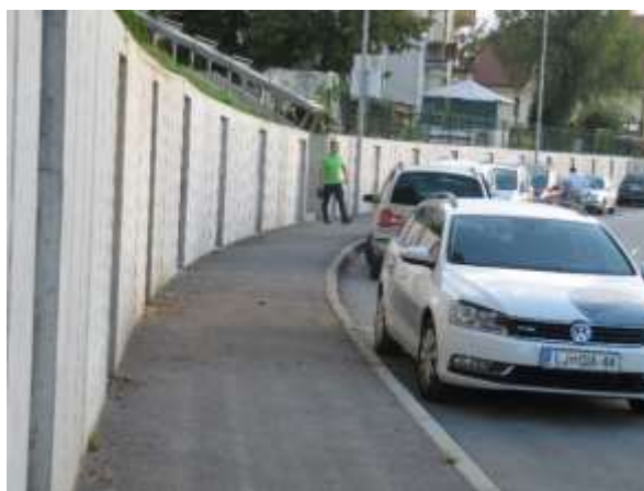
Slika 15: Parkirni prostori ob podpornem zidu
